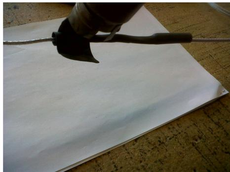
Schritt 6: Außenschrumpfschlauch aufföhnen
