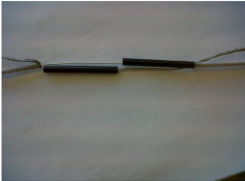
Schritt3: Schrumpfschlauch auf die Pressverbinder aufschieben
